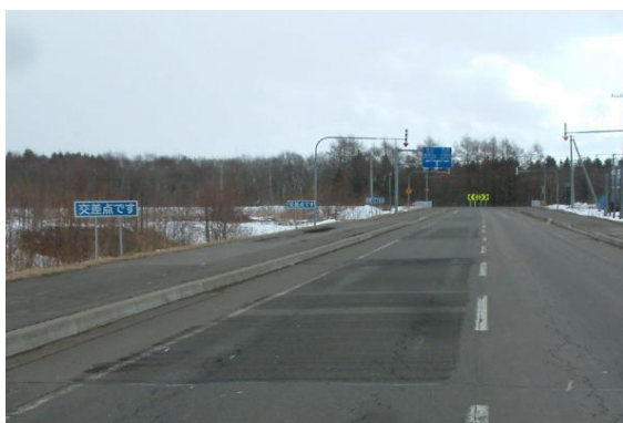
標津町「しゃべる道路」 交差点です、止まってください 音階、音量の特性を溝の一本一本に仕組んで擬音、擬声音を発生させる技術。
