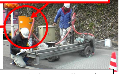
和歌山県紀美野町での施工写真
