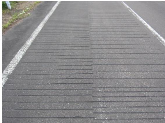
北海道標津町川北 知床旅情 左溝間隔—狭い—高音の発生 右溝間隔—広い—低音の発生
